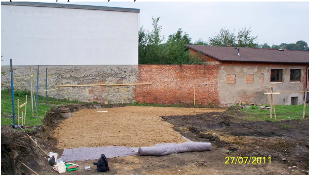
Budování přístupové komunikace ke stavbě
