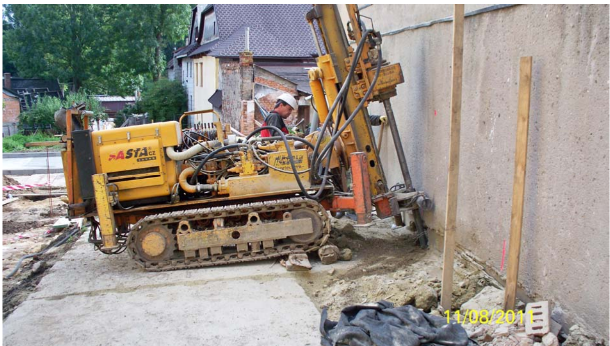
Provádění pilotáže
