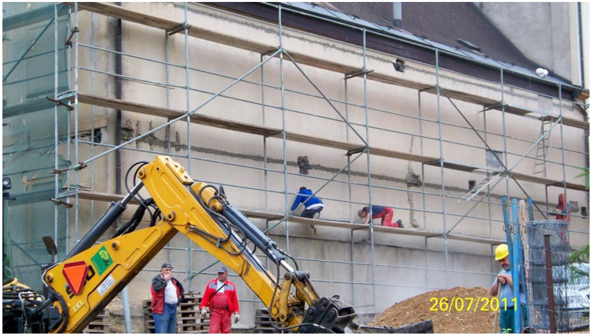
Sepínání budovy č.p. 11 ocelovými lany
