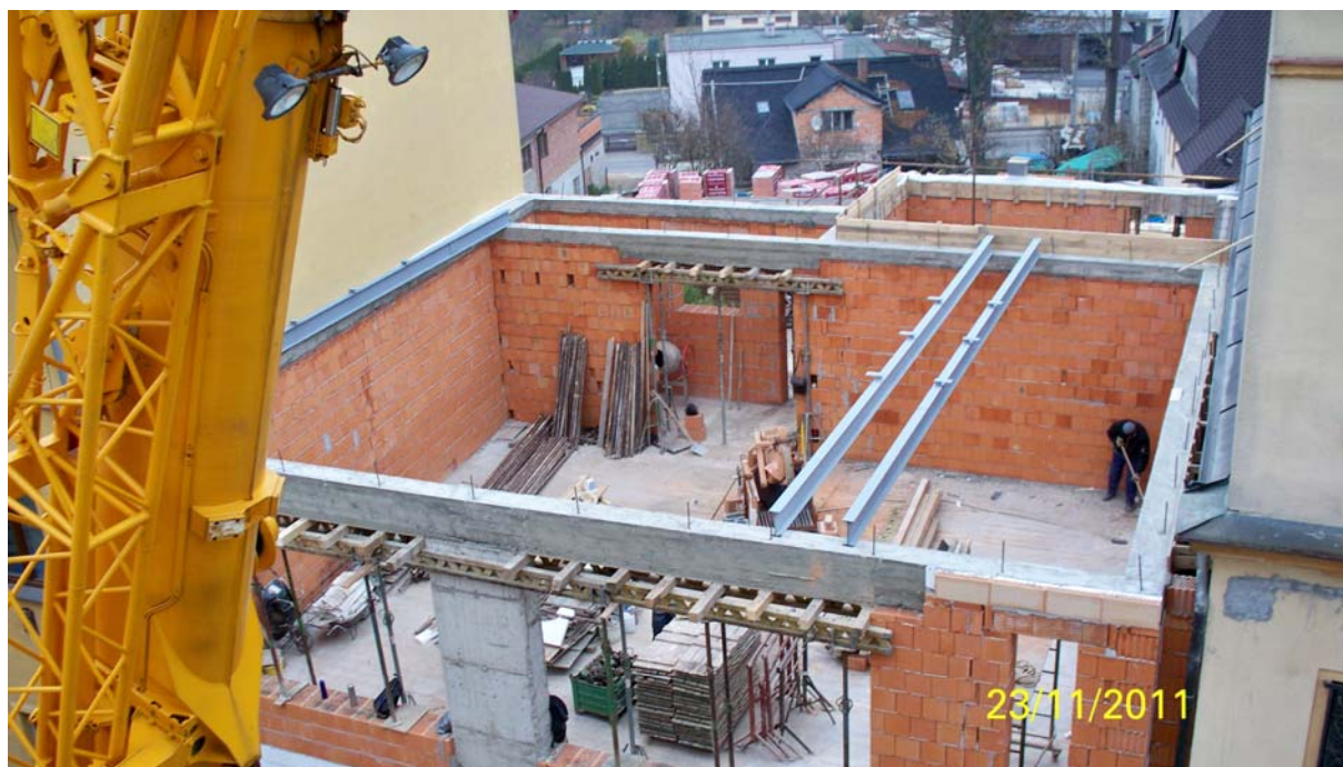
Příprava na pokládku stropních panelů
